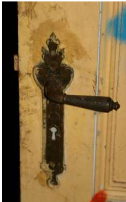
Afb. 10 Detail hal en trappenhuis. Waarschijnlijk originele deurklink toilet.
